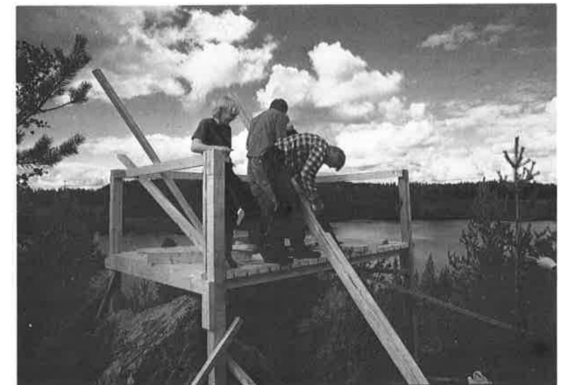
Olavinlammen rannan tarkkailutornista on hyvä näkyvyys yli koko lammen.
