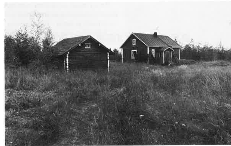
Pirhunvaaran rakennukset ovat kohtalaisessa kunnossa.
