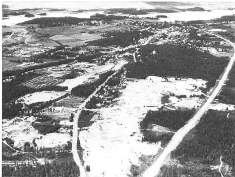
Kuva 7. Tuhoutunutta ja rakentamisen muuttamaa harjumaisemaa Porokylän Pitkämäellä Nurmeksessa—Vanhakylän harjualueella. Julkaistu Ilmailuhallituksen luvalla.
