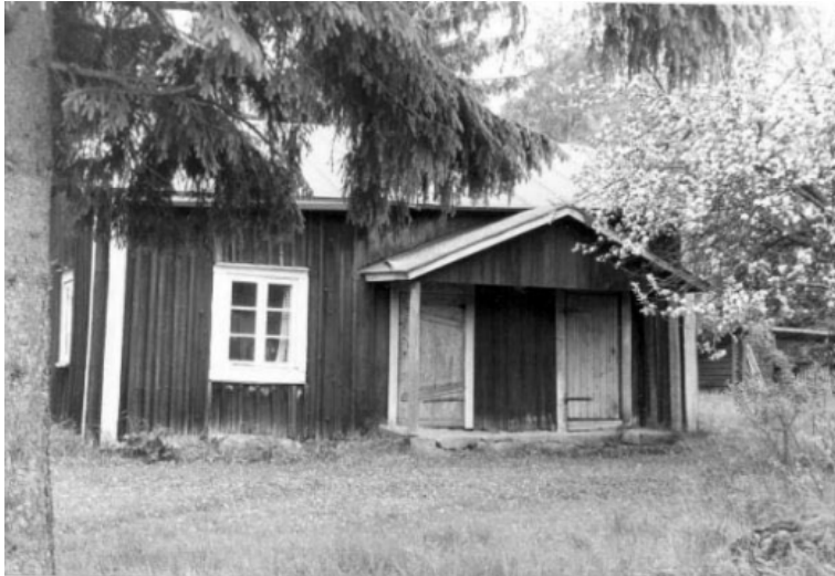
Syytinki ja työväenasunto kuvattuna vuonna 1987. Vasemmalla ikkuna, oikealla kolmionmallinen katos, jonka alla kaksi ovea. Etualalla oikealla kukkiva omenapuu. (14)
