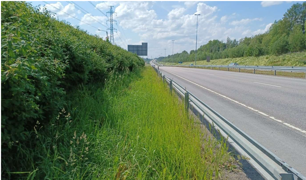
Kuva 2. Valtatie 6:n kapeimmat piennaralueet eivät olleet paljon metriä leveämpiä. Viereisen meluvallin peittävät sinikuusamaistutukset.
