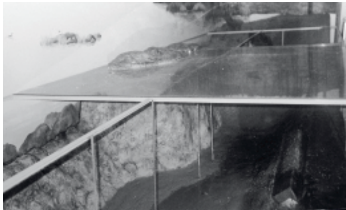
Järvidioraaman rakentamista. Kuva Pertti Kaarakainen
