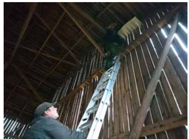
Petri Puolakka ja Kalle Raiskila (tikkailla) asentamassa kamerakalustoa.
